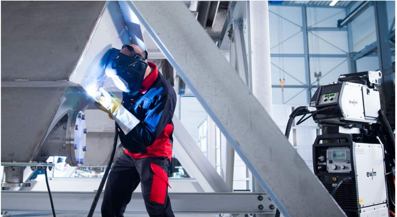
Bild 45: MAG-Schweißen eines Trichters aus CrNi-Stahl
